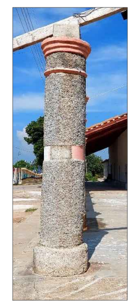
FOTO 2 Columna de tabique de barro rojo en el corredor.
