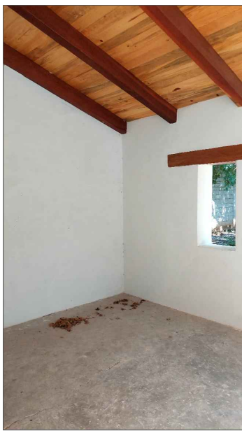
FOTO 2 Muro de 30 cm de espesor promedio en crujía 4.
