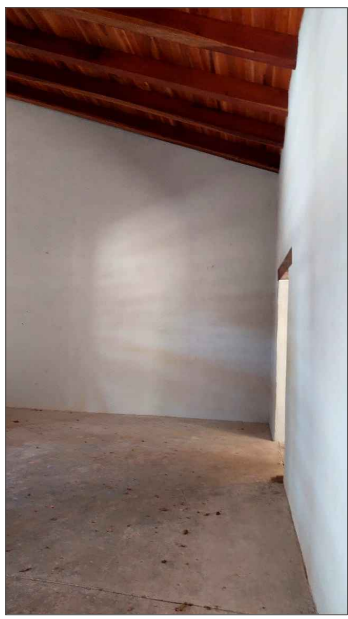
FOTO 3 Muro de 60 cm de espesor promedio en crujía 3.
